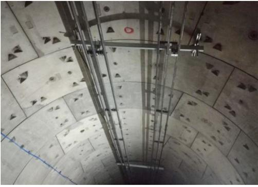
图6 典型矿用双动力类装备供电接触网
