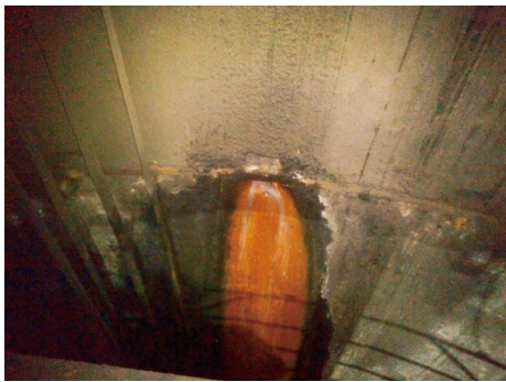
图 1 副井井壁渗漏水点照片
