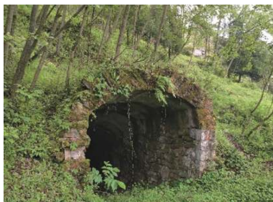
图 12 贵州张家湾普洒滑坡原始坡体坡脚处修筑的斜井入口
