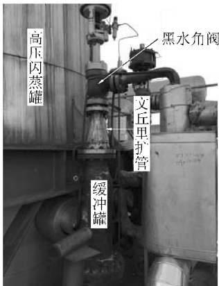
图 2 高压黑水角阀、出口文丘里扩管和缓冲罐
