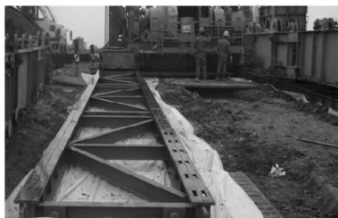
图5 棘轮棘爪式移动装置
