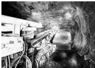
图2 邢东矿巷道掘进抛矸充填设备
