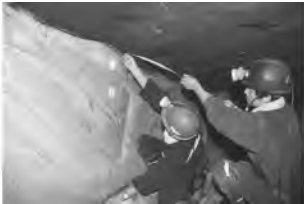
图6 田庄矿超高水充填接顶情况
