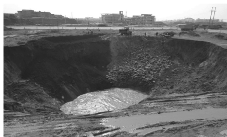
图1 曲江煤矿内4号塌陷形状
